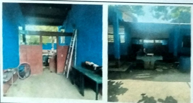
Foto 5: VISTA FONTAL MODULO DE COCINA, Levantado de muro de block sobre muro existente al ingreso de cocina.
