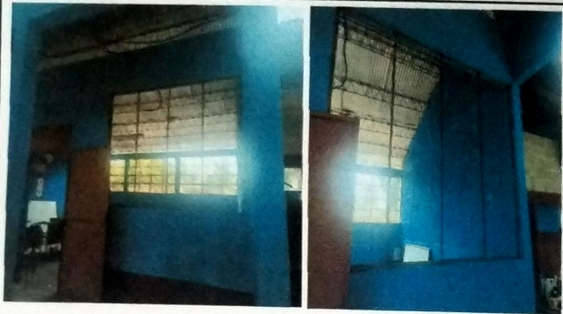
Foto 7: MODULO AULA mantenimiento de estructura metalica y cambio de lamina de zinc por lamina troquelada cal 26.
