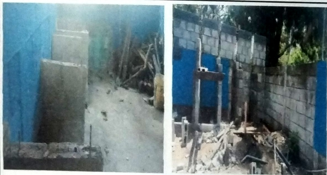
Foto 9: MODULO DE SERVICIOS SANITARIOS Vista de conformacion de cubiculos para sanitario.
