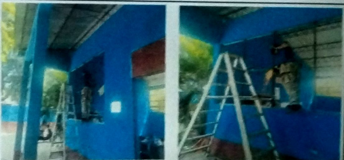
Foto 6: MODULO A mantenimiento de ventanería y refuerzo de la misma .
