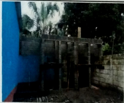
Foto 10: MODULO DE SERVICIOS SANITARIOS Vista de conformacion de cubiculos para sanitario.
