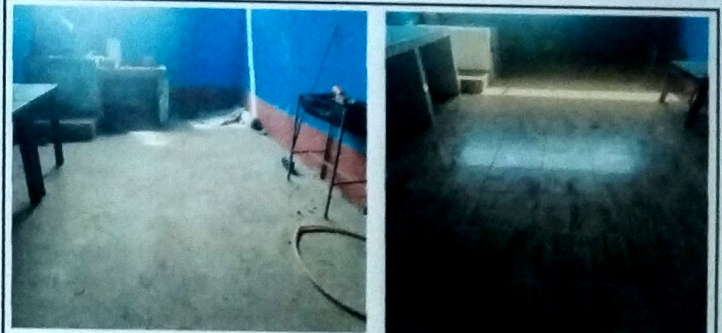
Foto 4: MODULO B COCINA Instalacion de piso ceramico
