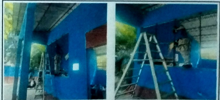
Foto 6: MODULO A mantenimiento de ventanería y refuerzo de la misma .
