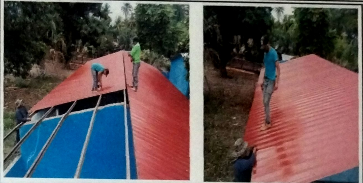
Foto 8: MODULO AULA mantenimiento de estructura metalica y cambio de lamina de zinc por lamina troquelada cal 26.
